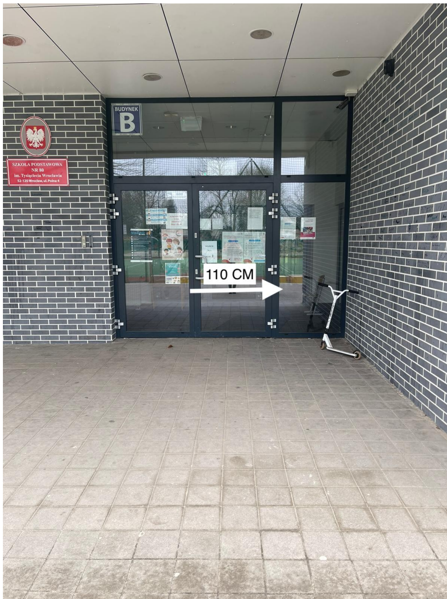
(zdjęcie przedstawia główne drzwi wejściowe do budynku B)
