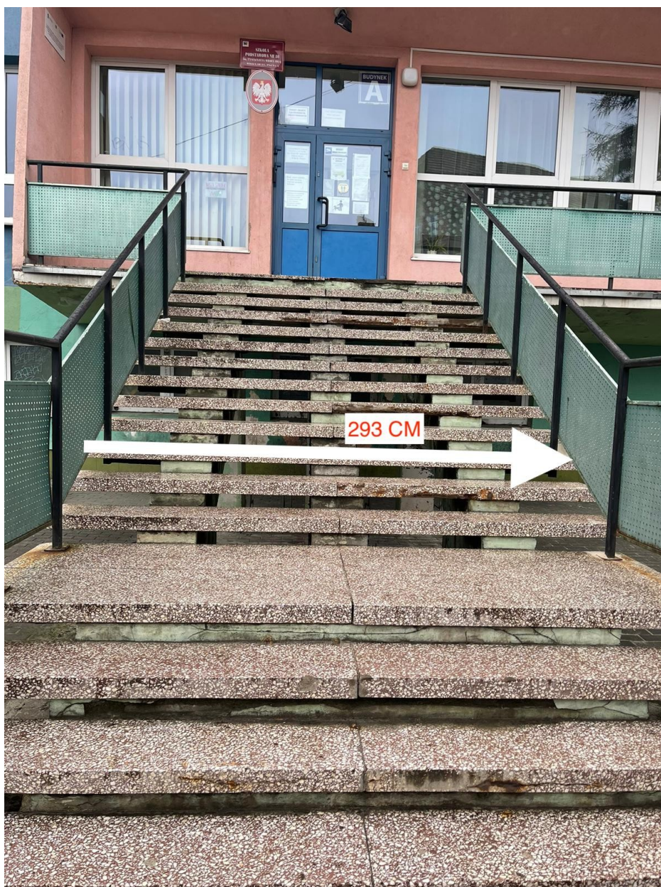
(zdjęcie przedstawia schody prowadzące do wejścia głównego budynku A)
